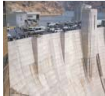
Los diques de contención y los embalses están diseñados para recoger y guardar el agua de la superficie.
